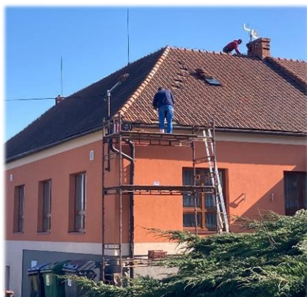
Oprava hřebenu střechy na kulturním domě a výměna prasklých tašek
